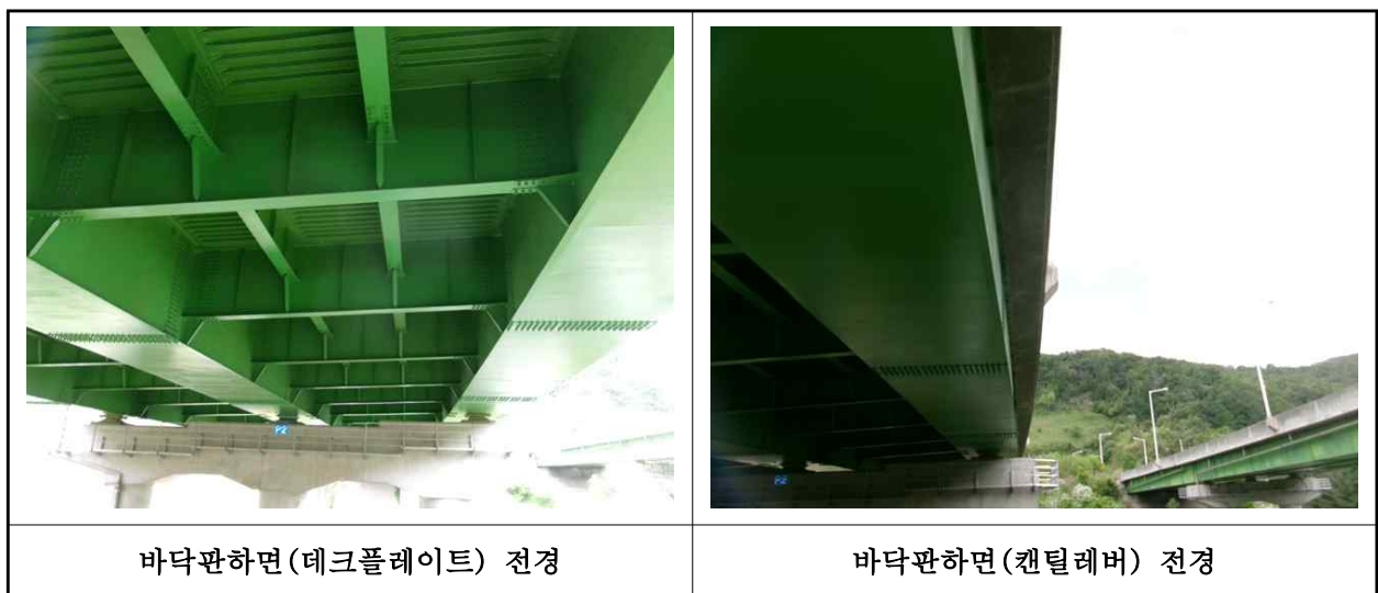
【사진 1.3.2】 바닥판하면 전경
