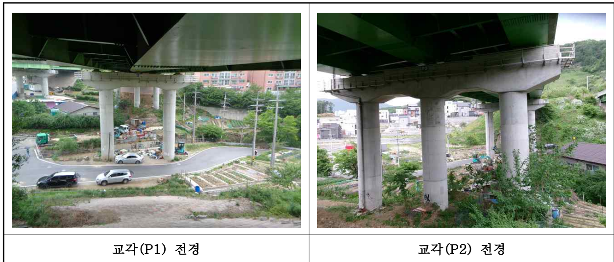
【사진 1.3.10】 교각 전경
