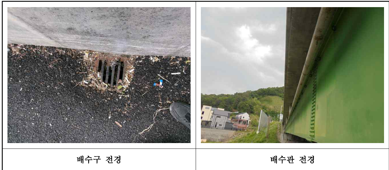
【사진 1.3.21】 배수시설 전경
