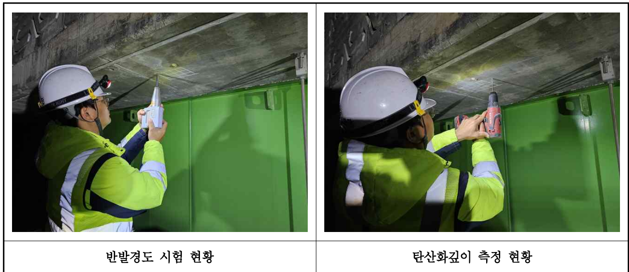
【사진 1.4.1】 콘크리트 내구성조사 현황
