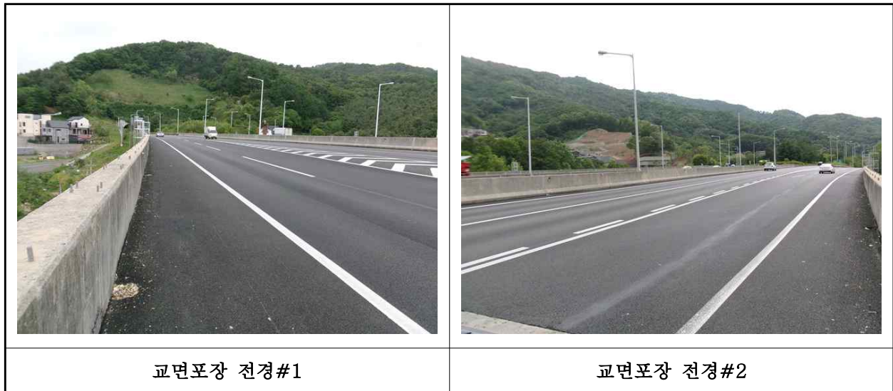
【사진 1.3.19】 교면포장 전경
